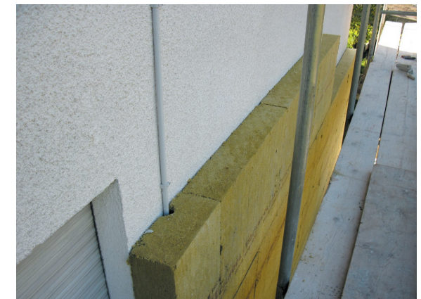
isolamento parete esterna
