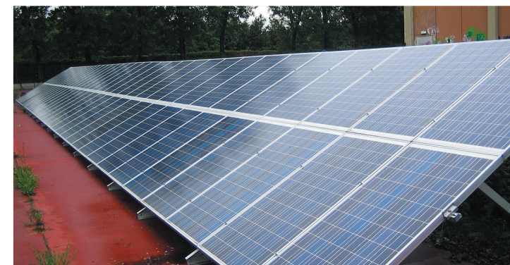
impianto fotovoltaico a terra
