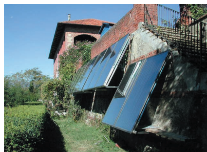
impianto solare piano
