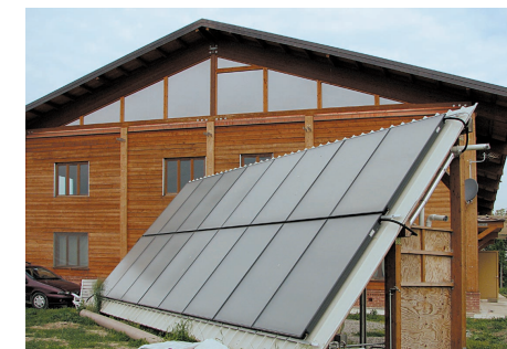
Impianto solare piano combinato (acqua calda sanitaria e riscaldamento)
