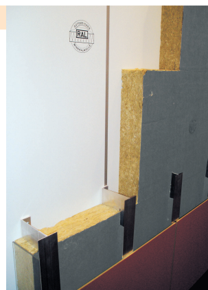
esempio di isolamento a cappotto
