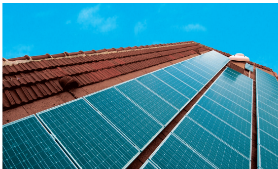
impianto fotovoltaico parzialmente integrato
