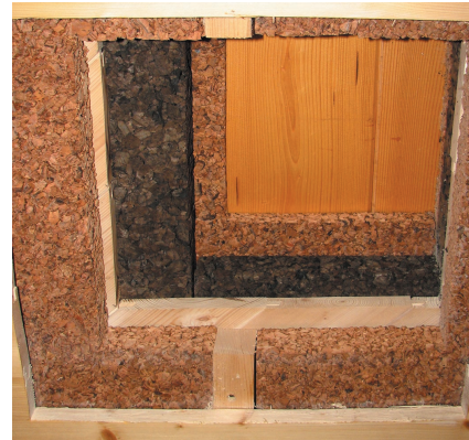
isolamento con pannelli di sughero
